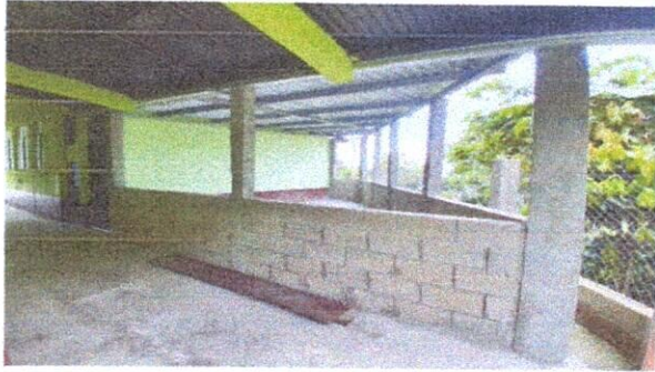
Foto1: Mejoramiento de aula estilo pórtico, con entechado de lamina troquelada, alisado de piso e instalación de energía.
