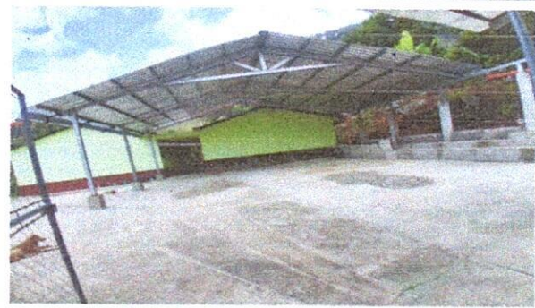
Foto 2: Mejoramiento de Cubierta de Patio
